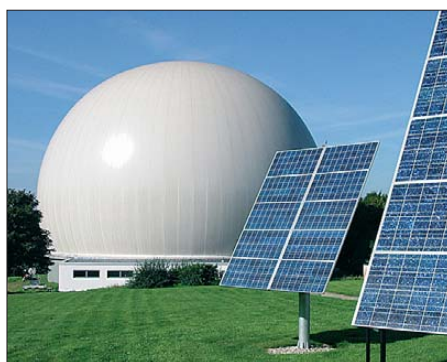
Bild 15: Radom (Radarkuppel) der Sternwarte Bochum/Institut für Umwelt- und Zukunftsforschung (IUZ) mit der darin verborgenen Parabolantenne
