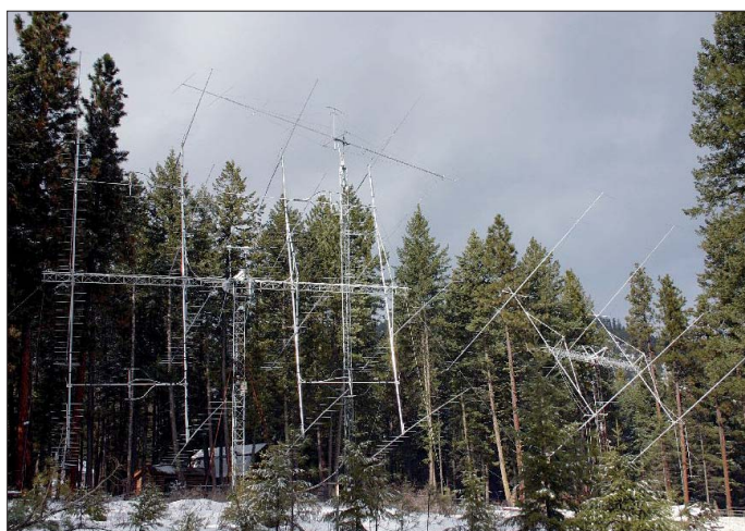
In Montana hat man noch viel Platz: W7GJs Antennenfarm – von links 16 x 17-Element-Yagi-Antennen für 2 m, Elfelement-Yagi und 4 x Neunelement-Beams für 6 m Foto: W7GJ
